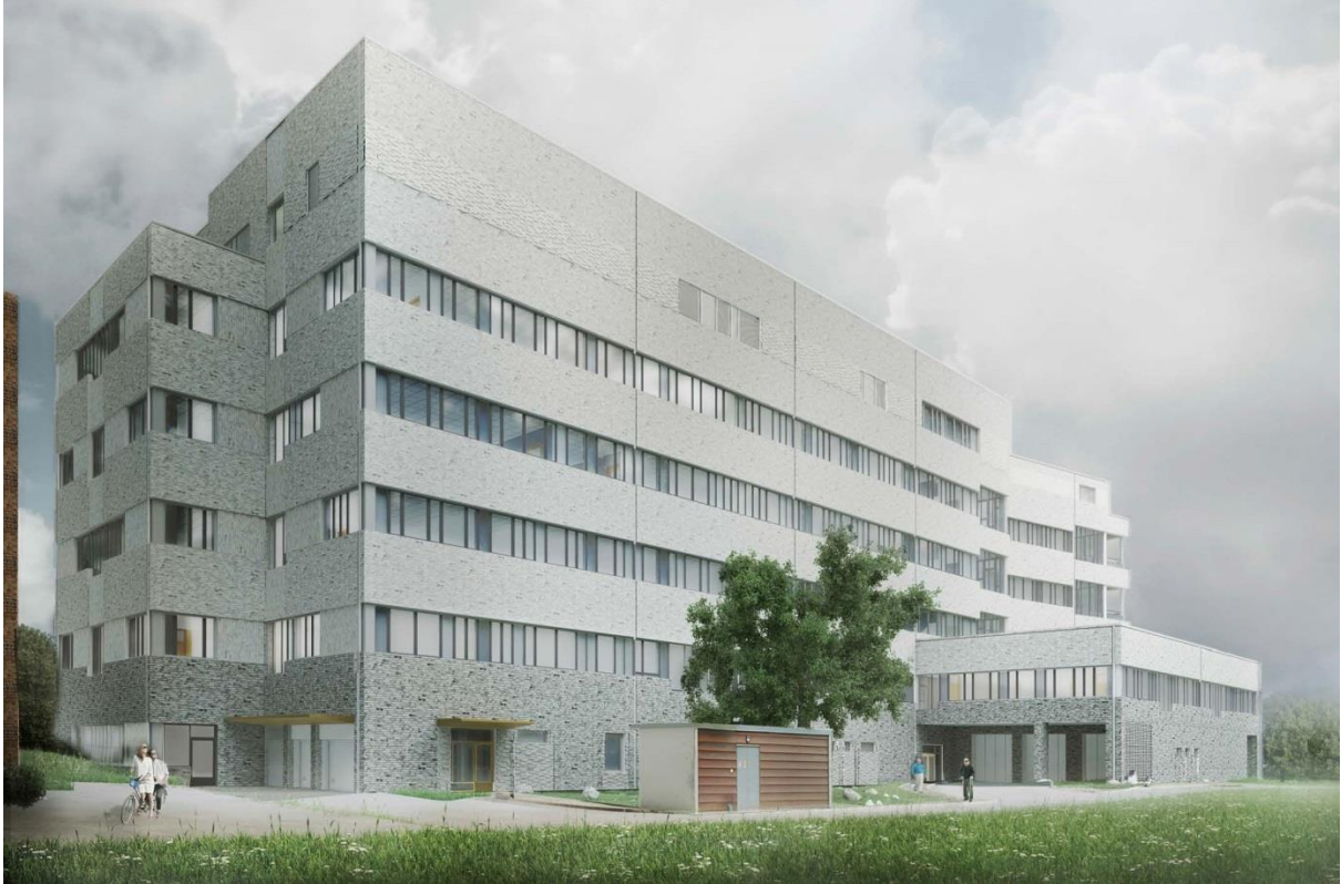
Bild 4 – Byggnad 46 västra fasaden med personalentré
